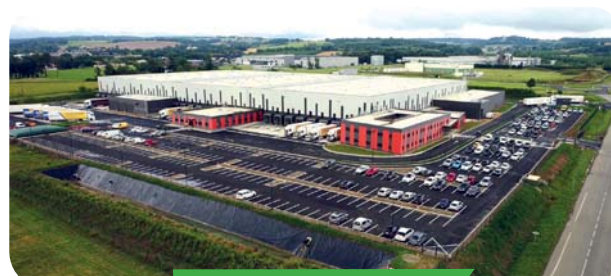
Nouvelle plateforme Biocoop à Damazan (47).
