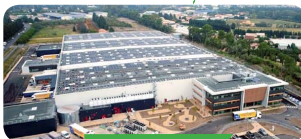
Nouvelle plateforme Biocoop à Noves (13).
